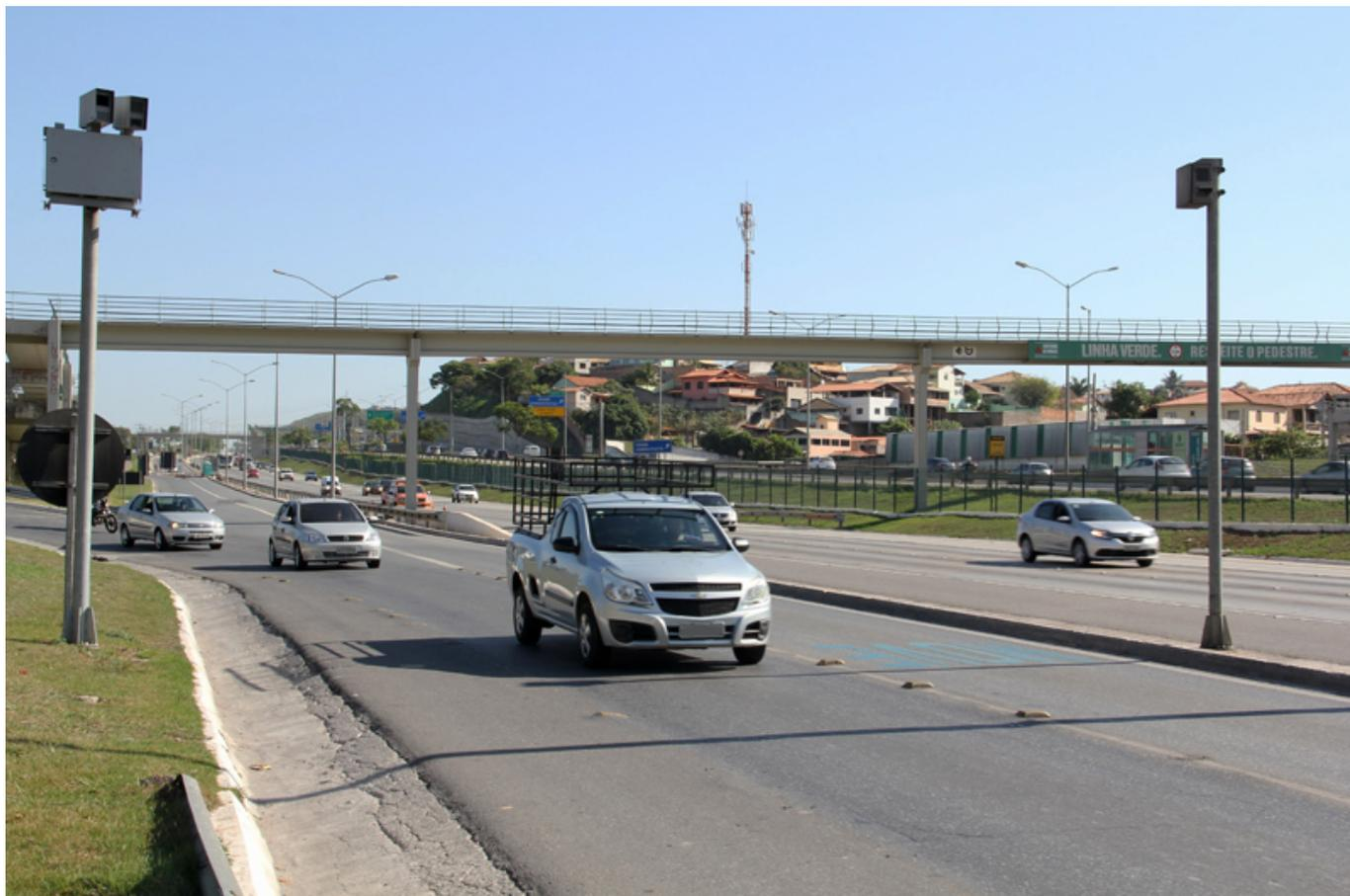
Dos equipamentos que entram em operação a partir do dia 25, treze são do tipo controlador eletrônico de velocidade, aqueles que não possuem display. Outros oito equipamentos são redutores eletrônicos de velocidade, estes equipados com display que mostra a velocidade dos veículos na passagem pelos sensores.
